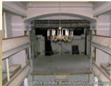
Blick auf die Bühne während Sanierung
